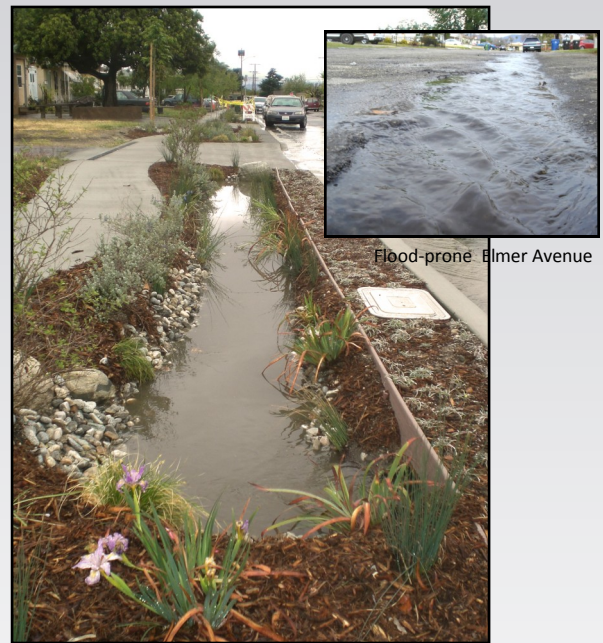
Elmer Avenue bioswale
